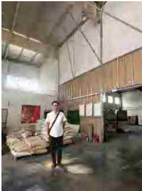
工程师现场踏勘照片
