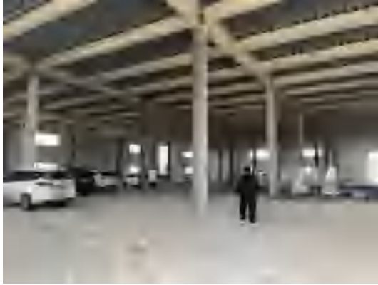
项目厂房现状
