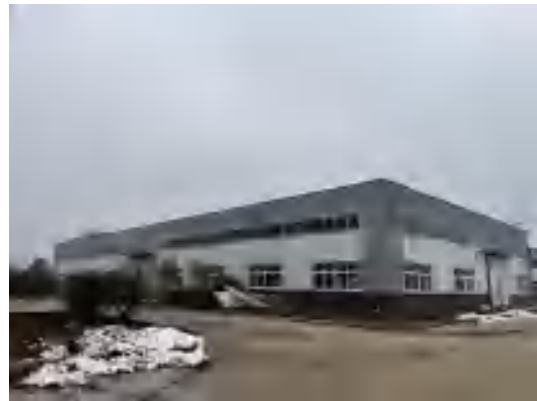
项目西侧空置厂房
