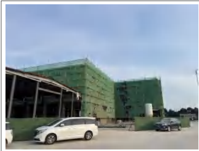
项目现场照片
