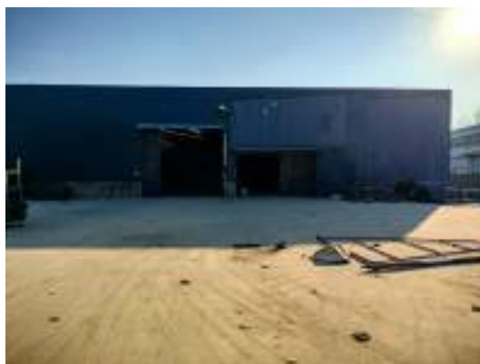
项目位置及厂区现状
