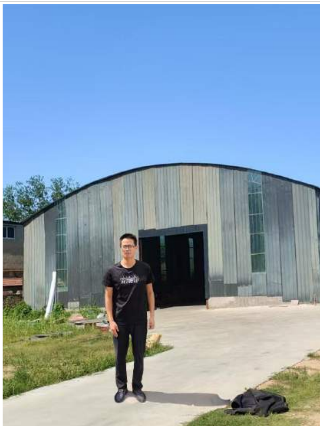
工程师现场踏勘照片
