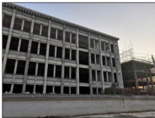
项目车间南侧在建厂房
