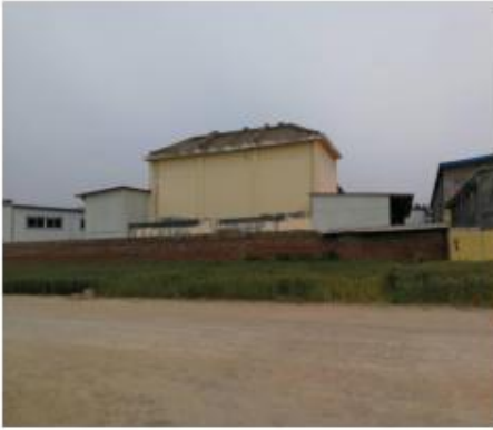
项目东侧 集聚区道路及厂房
